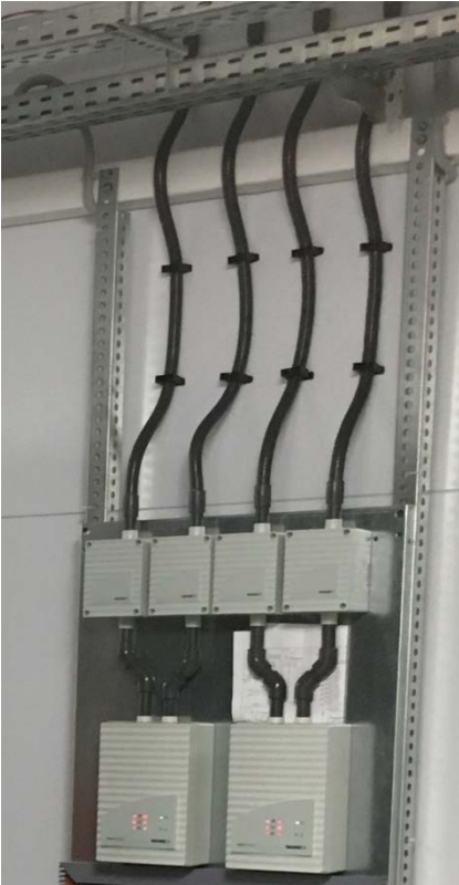
Рис. 6.3, Пример реализации гибких соединений с использованием шланга SCH-P25
