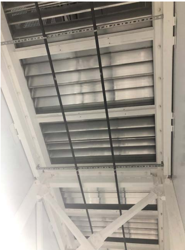
Рис. 3.6, Аспирационные трубы с воздухозаборными отверстиями на потолке изолированного «горячего коридора»
