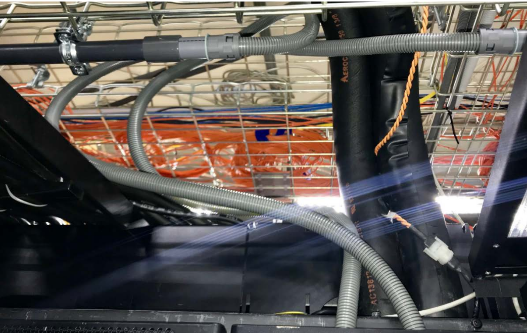
Рис. 6.4, Пример реализации гибких, разборных соединений с использованием шланга SCH-PG16
