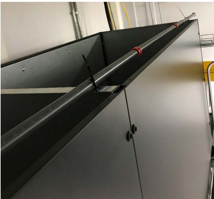
Рис. 3.8, Аспирационные трубы с воздухозаборными отверстиями на входе «горячего воздуха» в прецизионный кондиционер
