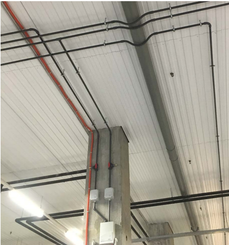
Рис. 6.2, Пример реализации гибких соединений с использованием шланга SCH-P25
