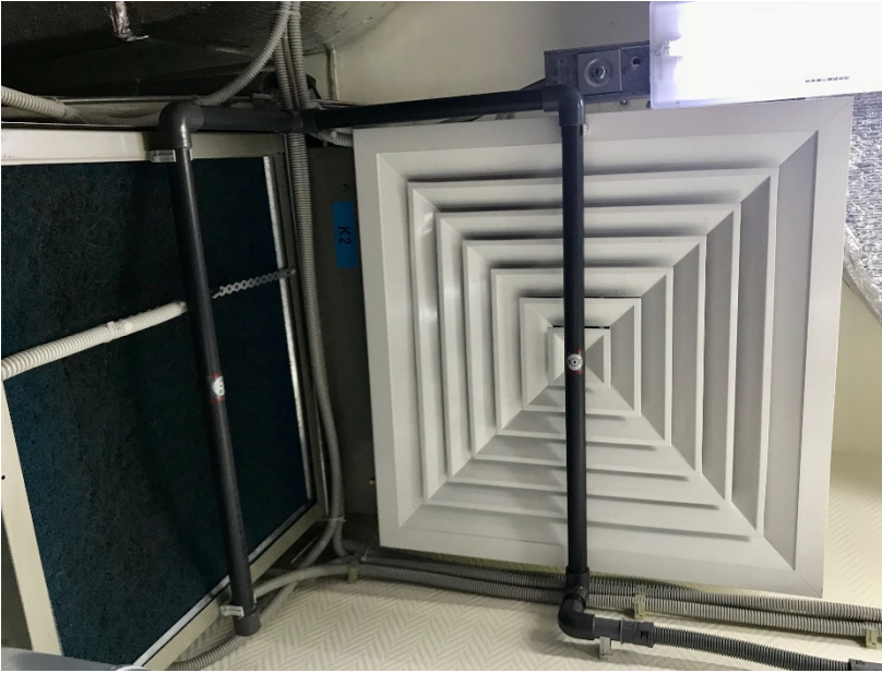
Рис. 3.5, Аспирационные трубы с воздухозаборными отверстиями перед решеткой входа «горячего» воздуха в систему охлаждения
