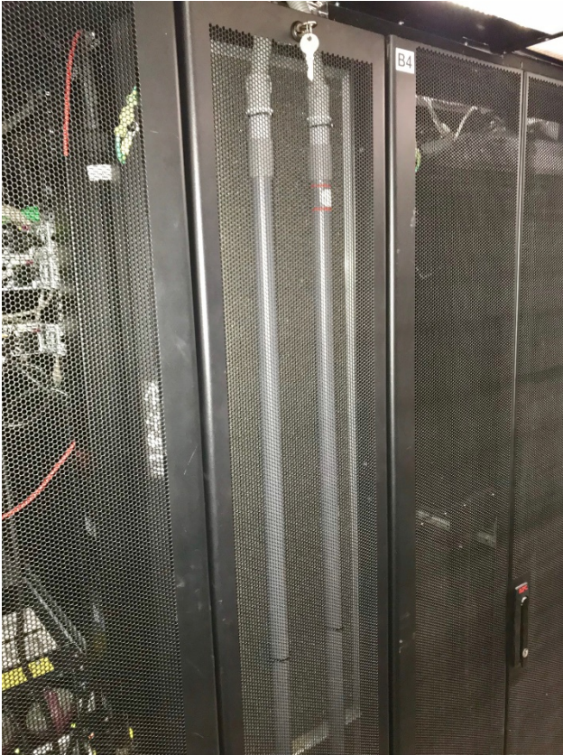
Рис. 3.7, Аспирационные трубы с воздухозаборными отверстиями на решетке входа «горячего воздуха» в систему межрядного кондиционирования
