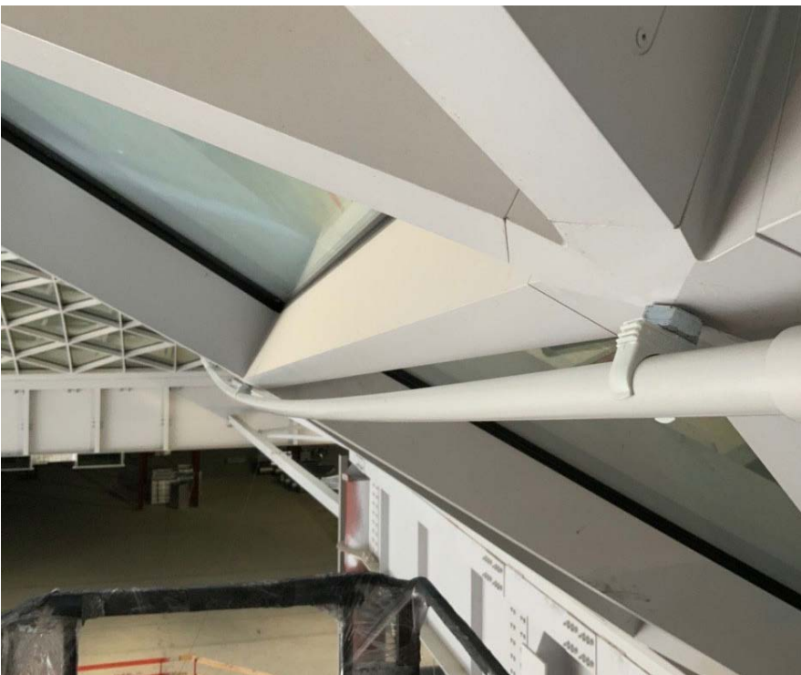
Рис. 2.8, Аспирационная труба, покрашенная в цвет металлических конструкций
