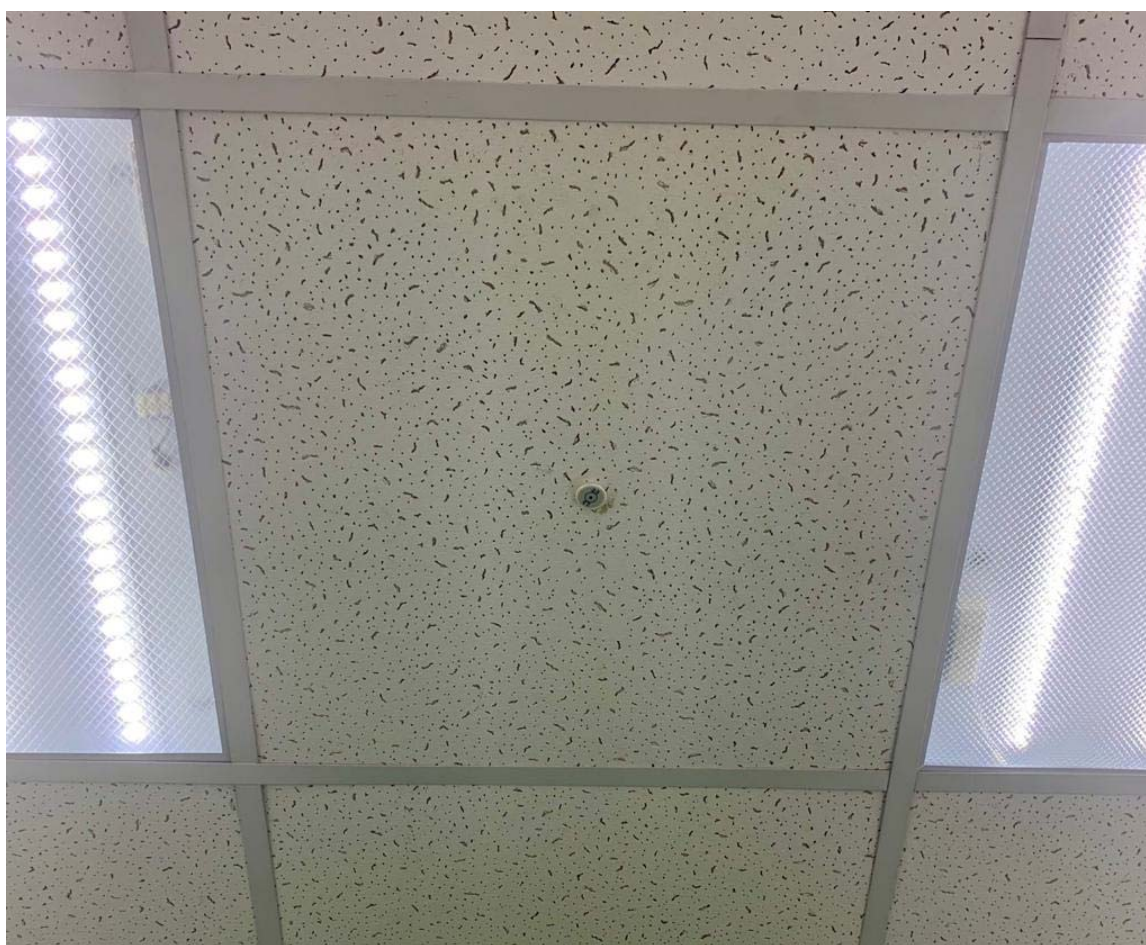
Рис. 4.5.1, Пример расположения воздухозаборного отверстия аспирационного извещателя в непосредственной близости от осветительных приборов
