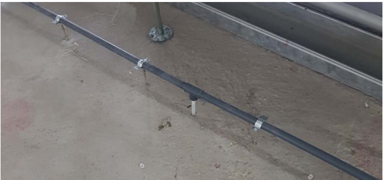
Рис. 4.2.2, Пример размещения аспирационных труб в конструкции здания
