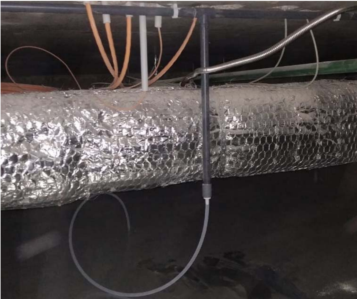
Рис. 4.2.4, Пример размещения аспирационных труб за подвесным потолком
