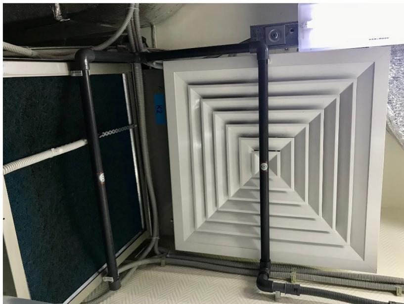
Рис. 3.5, Аспирационные трубы с воздухозаборными отверстиями перед решеткой входа «горячего» воздуха в систему охлаждения
