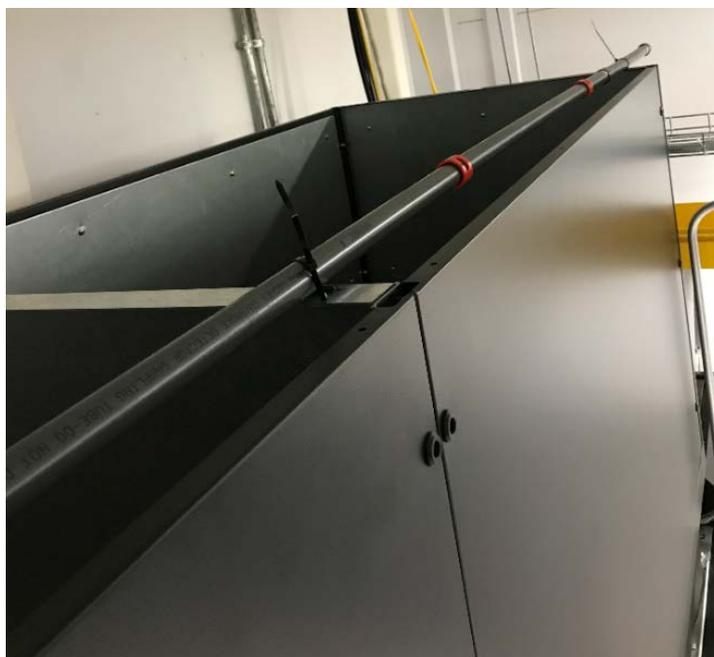
Рис. 3.8, Аспирационные трубы с воздухозаборными отверстиями на входе «горячего воздуха» в прецизионный кондиционер
