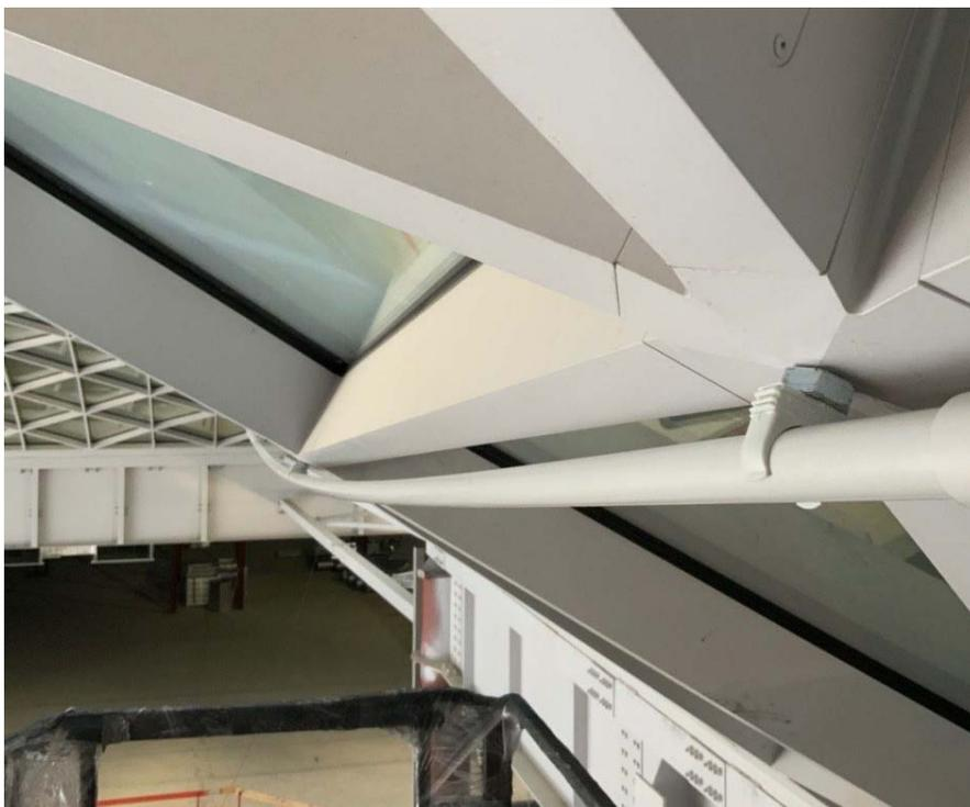
Рис. 2.8, Аспирационная труба, покрашенная в цвет металлических конструкций
