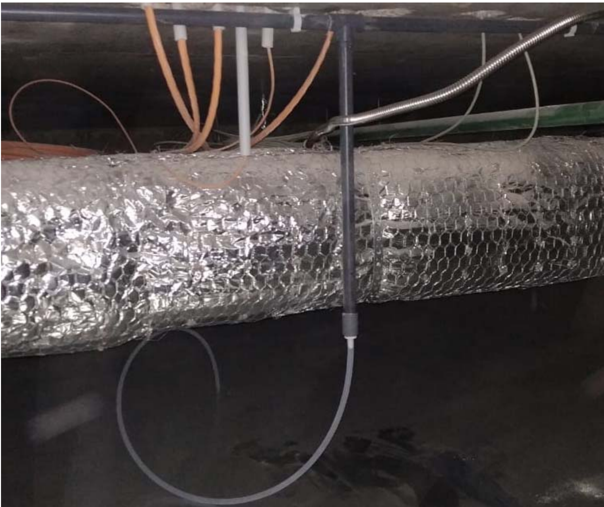
Рис. 4.2.4, Пример размещения аспирационных труб за подвесным потолком
