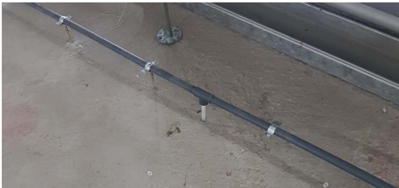
Рис. 4.2.2, Пример размещения аспирационных труб в конструкции здания
